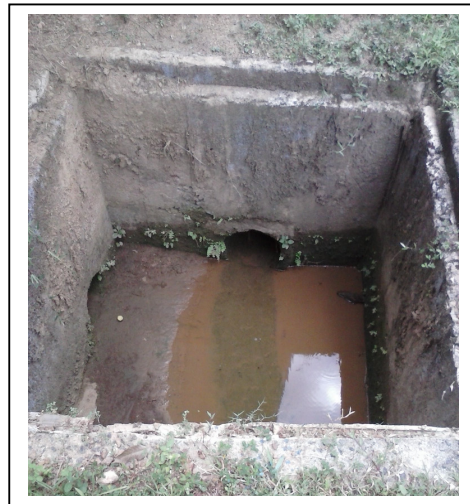
ඉදිකෙරෙමින් පවතින මඩ වියලන පොකුණු. (Sludge Drying Beds)
