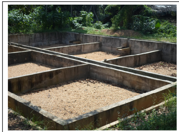
ඉදිකෙරෙමින් පවතින මඩ වියලන පොකුණු. (Sludge Drying Beds)
